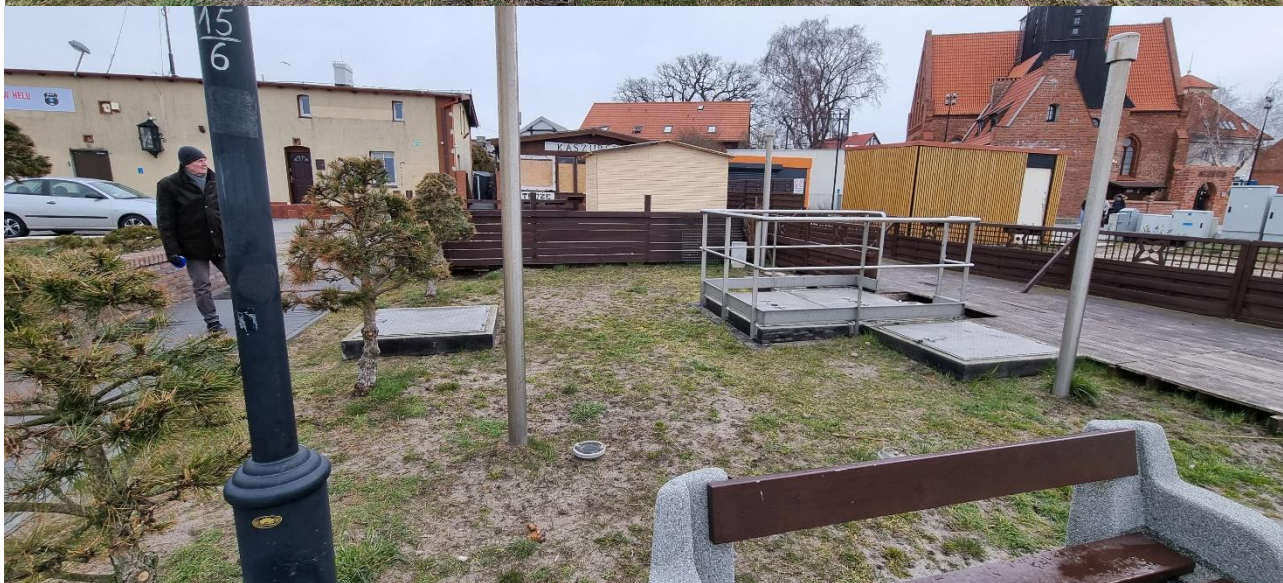
Fot. 1,2 teren inwestycji – stan istniejący, widoczne klapy rewizyjne zbiornika na deszczówkę
